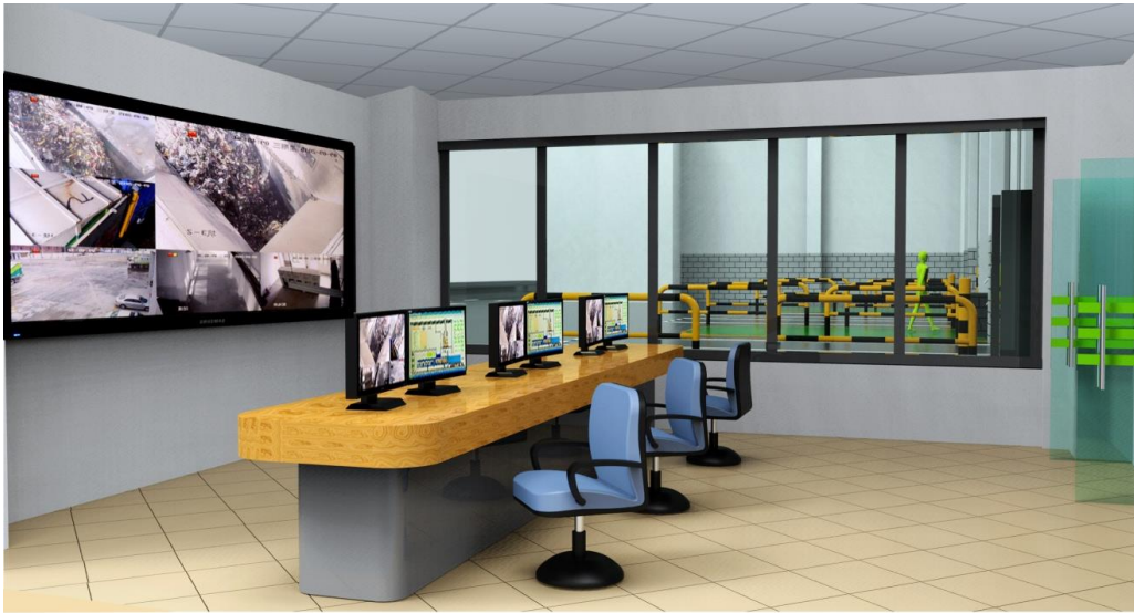
全自动化集中控制系统控制全站运行
