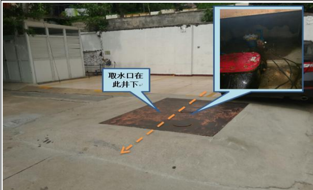
现场照片（管道全埋）
